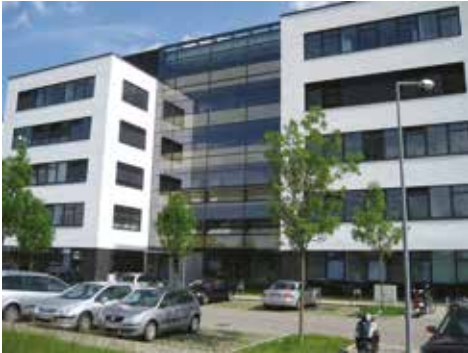
Abb. 1 Bürogebäude (Quelle: ebök)
